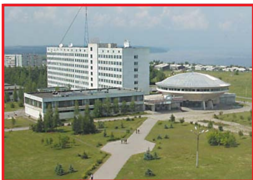
Комплекс зданий учебного корпуса, библиотеки и актового зала
